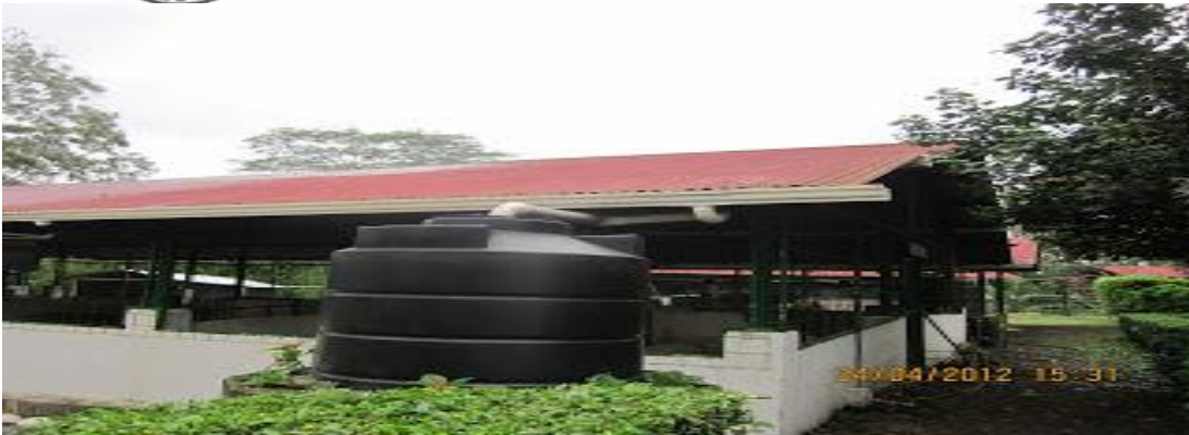
Orientación y techos porqueriza integrada
